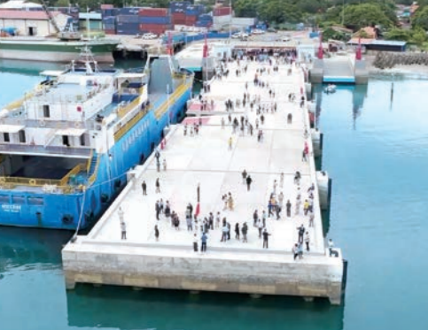
国内唯一の国際港湾として機能するディリ港。既存のフェリーターミナルを無償資金協力により移設・拡張し、安全かつ効率的な海上輸送の拡大に貢献（東ティモール）
